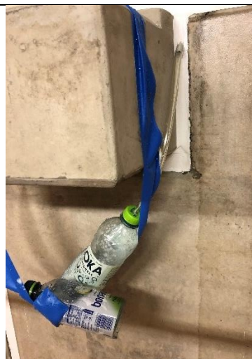
Utökat försök 2 för att kontrollera täthet vid balkong.
