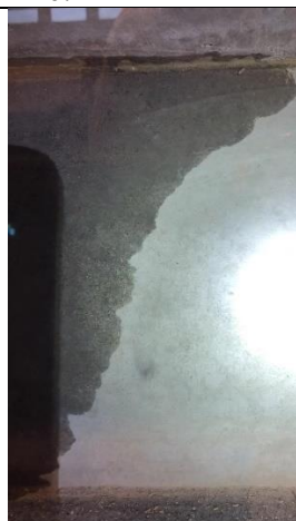
Fuktmarkering på väggen i inspektionsöppning.
