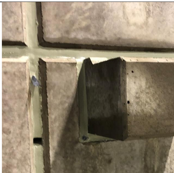
Fogkors och balkonganslutning med fogmassa.
