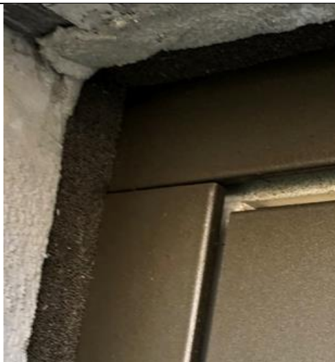
Skarv i metallbeklädningen vilket är ett exempel på glipa där vatten eventuellt kan tränga in bakom detta fogband.
