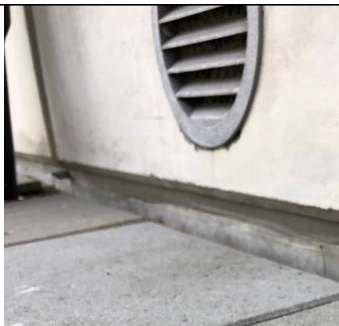
Vägganslutning mot grund. Horisontellt placerat TDV-rör.
