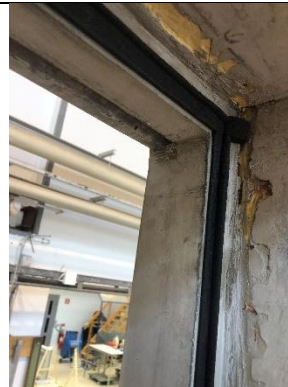
Yttre fogband i fönsteröppning.
