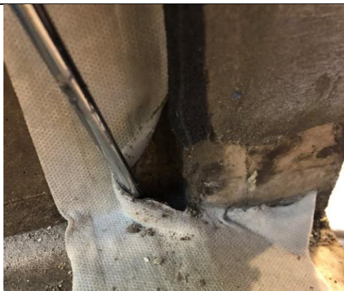
Sekundär tätning hade släppt i hörnet vilket kan vara en trolig förklaring till inläckageväg.
