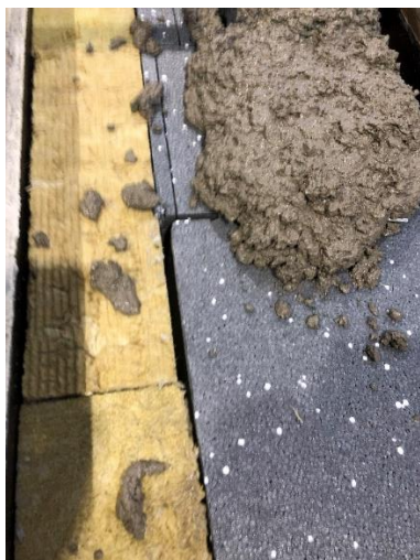
Figur 1. Exempel på gjutning av betongsandwichelement. Pågående gjutning av den andra betongskivan. I denna del av elementet användes mineralullsisolering närmast fönsteröppning och i övrigt EPS.
