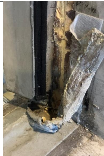
Sekundär tätning hade släppt i det vänstra hörnet vilket kan vara en trolig förklaring till inläckageväg.
