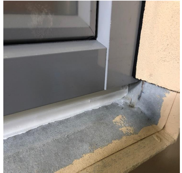
Bild 2.8. Vattenutledningen är monterad under fönster samt att det har tätats med fogmassa under fönster.
