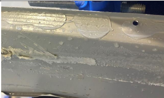
Punktvis med fogmassa på fönsterbleckets bakkant. Lägg märke till att plåtkanten som ska in i karmspåret är sannolikt för bred.
