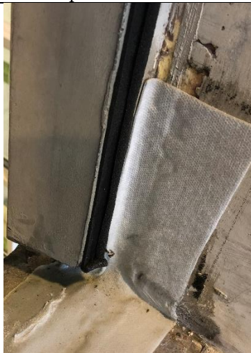
Uppvik av sekundär tätning.
