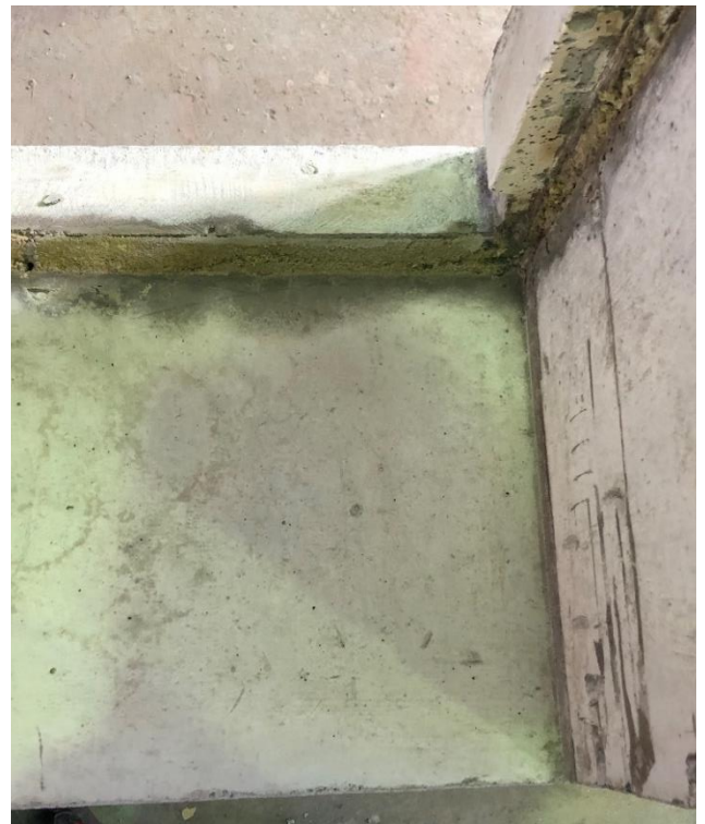
Bild 2.12. Isoleringen i väggen är delvis synlig mellan den yttre och inre betongskivan.
