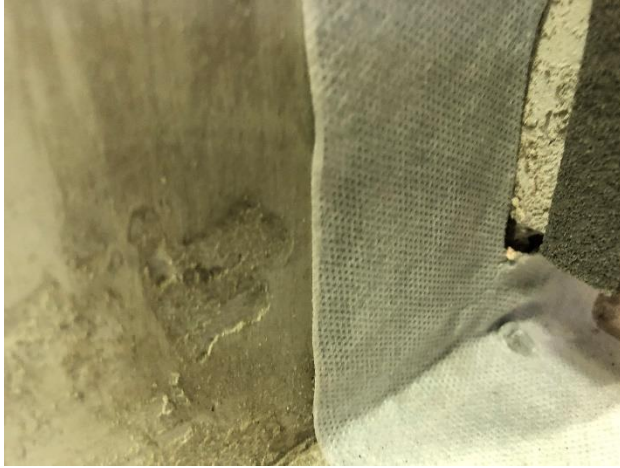
Bild 2.5. Monterad vattenutledning vid fönsterbröstning. Det ser ut som tätbandet inte täcker isoleringen i väggen och att det finns en glipa/hål.
