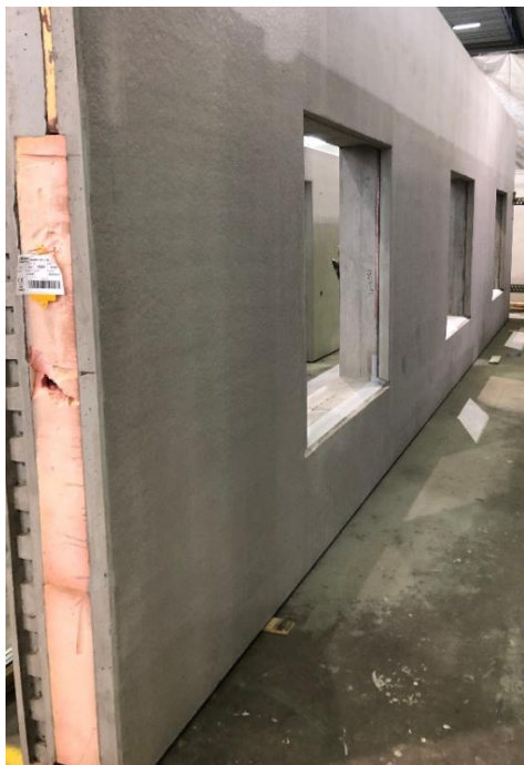
Bild 2.1. Lagring av betongsandwichelement efter gjutning och efter montering av vattentutledning vid fönsterbröstning.
