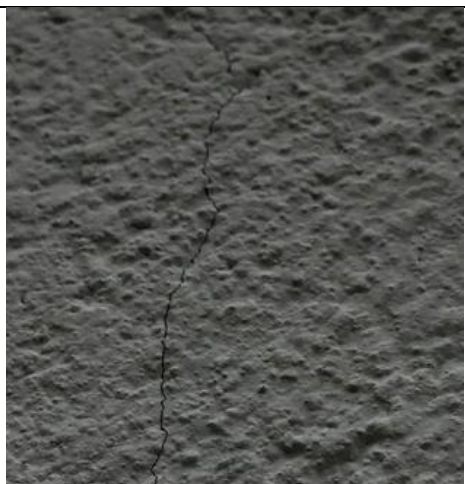
Vertikal spricka i puts utanför betongelementsskarv.
