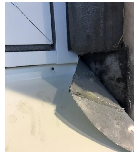
Fogmassa mellan uppvik av fönsterbleck och betongsmyg.
