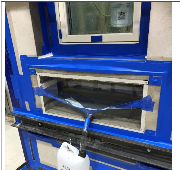
Uppsamling av vatten inuti vägg under fönster A10.
