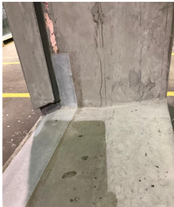
Bild 2.2. Monterad vattentutledning vid fönsterbröstning.
