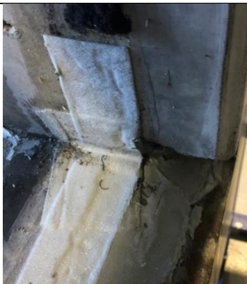
Sekundär tätning hade släppt i det högra hörnet vilket kan vara en trolig förklaring till inläckageväg.
