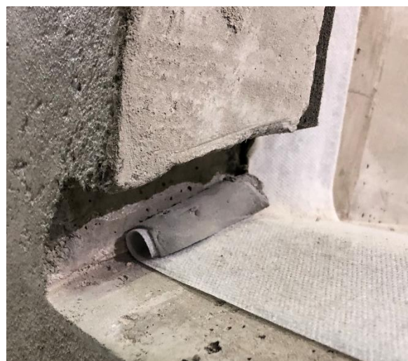
Bild 2.4. Monterad vattentutledning vid fönsterbröstning. Det ser ut som att tätbandet delvis har släppt från underlaget vid uppdrag.
