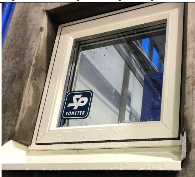
Fönster nr 1 (B1-B4).
