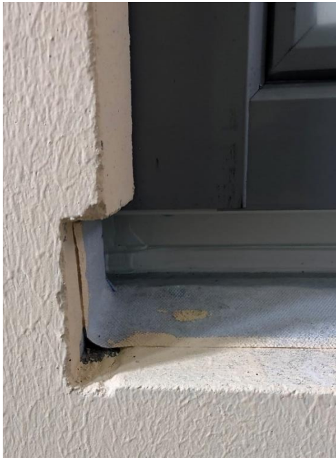
Bild 2.9. Vattenutledningen är monterad under fönster. Den tätar inte i hörnet. Lägga märken till att den är snittad i den andra vinkeln längre in vilket är en känslig punkt.
