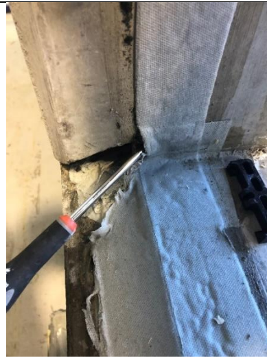
Sekundär tätning hade släppt i det vänstra hörnet vilket kan vara en trolig förklaring till inläckageväg.
