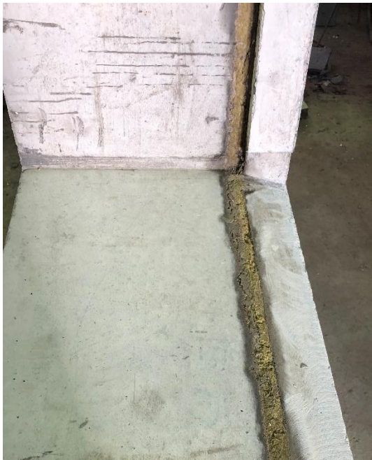
Bild 2.7. Fönsterbröstning före montering av vattenutledning.
