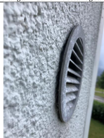
Eventuellt saknas tätning av ventilgenomföring.
