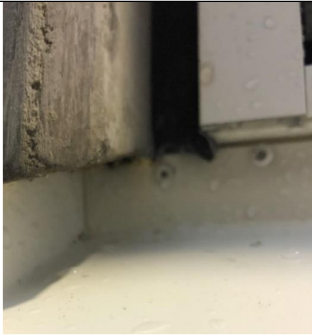
Fönster och fönsterblecksanslutning vid det nedre vänstra hörnet.
