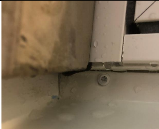
Fönster och fönsterblecksanslutning vid det nedre vänstra hörnet.
