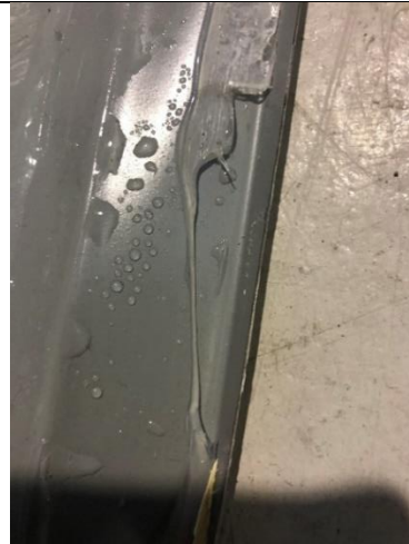
Punktvis med fogmassa på fönsterbleckets bakkant.
