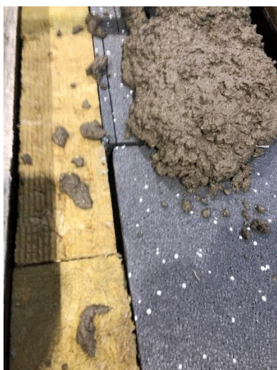
Bild 2.3. Pågående gjutning av den andra betongskivan som ska bli ett betongsandwichelement.
