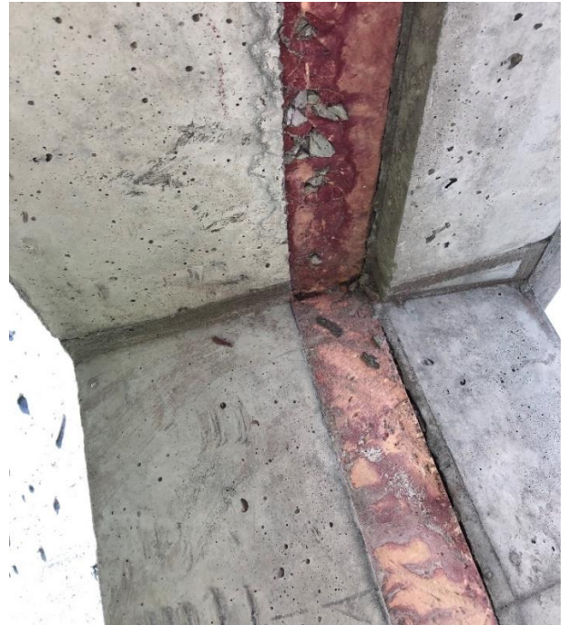
Bild 2.10. Isoleringen i väggen är synlig i fönsteröppning mellan den yttre och inre betongskivan.
