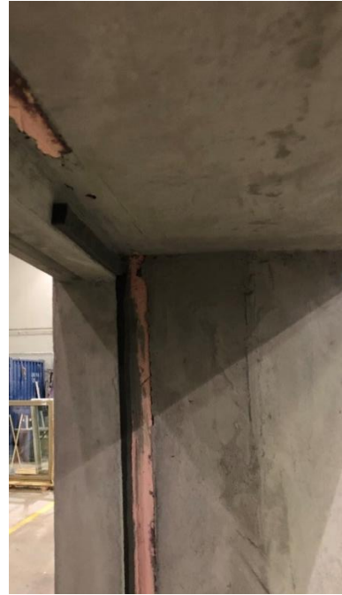
Bild 2.6. Pågående montering av expanderande fogband (yttre fogband).
