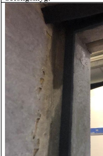
Fuktmarkeringar på betong innanför det yttre fogbandet.
