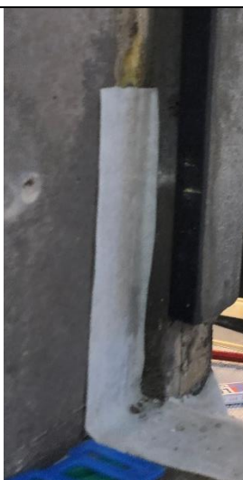
Uppdrag sekundär tätning vid det nedre högra hörnet sett inifrån.
